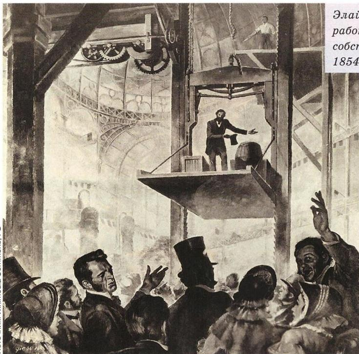
*Элайша Отис демонстрирует работу ловителя кабины лифта собственной конструкции 8 мая 1854 года. Копия гравюры.*
