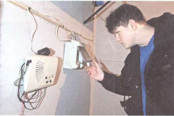
Матвей Шипко раз в неделю поверяет башенные часы на Привокзальной площади
